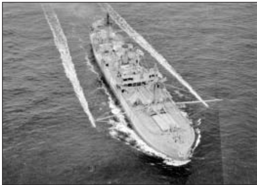
NAVIRE MARCHAND MUNI DE FILETS ANTI-TORPILLES, PRÈS DE SYDNEY (N.-É.). (ANC PA152034)
